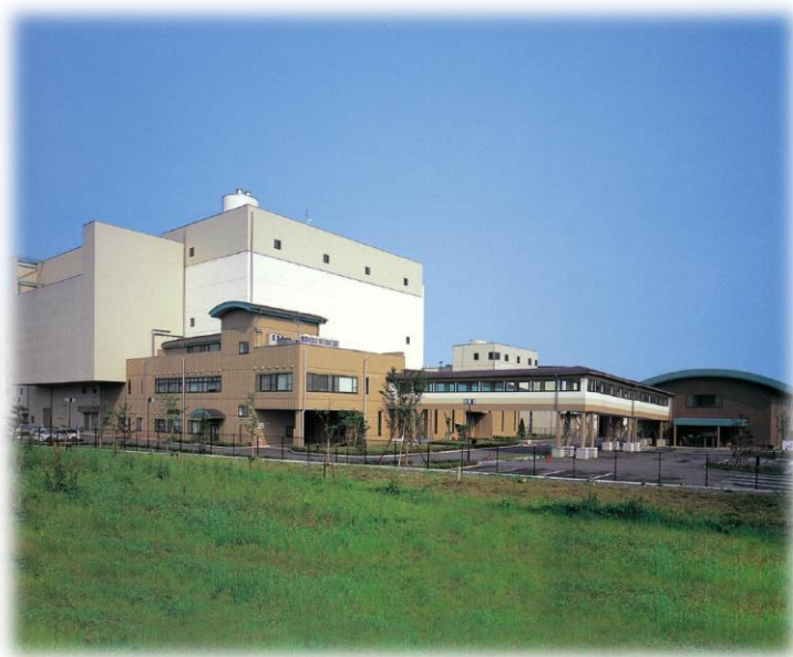
可燃ごみ処理施設及び不燃ごみリサイクル施設
