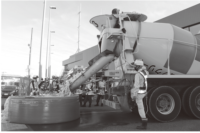
〔ミキサー車からの給水の様子〕
