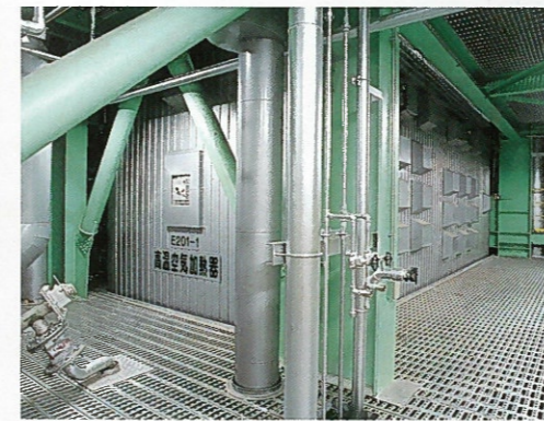
■高温空気加熱器 燃焼用排ガスから熱回収を行い、熱分解の熱源となる高温空気を作り出します。
