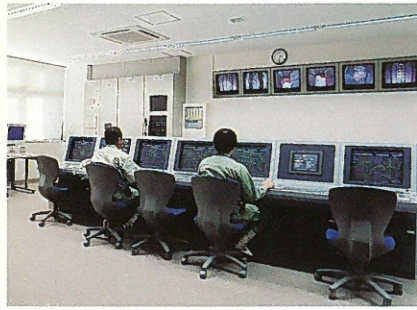
■中央操作室 施設内にある設備の運転や管理・監視をここで行うことができます。
