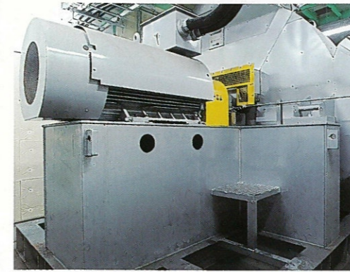
■加熱空気送風機 高温空気を熱分解ドラムと高温空気加熱器の間で循環させます。
