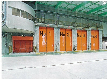
■プラットホーム 収集車がごみを投入する場所です。
