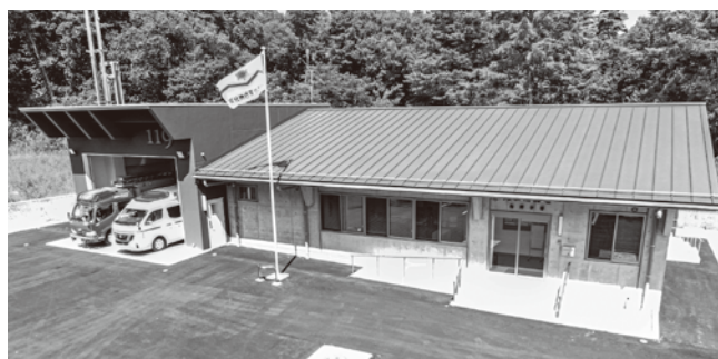
北杜消防署白州分署（北杜市白州町鳥原2913番地165）
